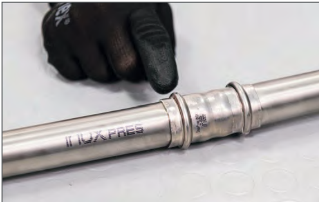
Controllo della pressatura / Checking the press connection
