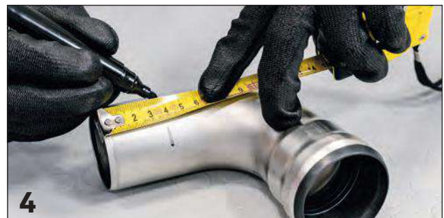
4 Marcatura quota d'innesto / Marking the insertion's depth
