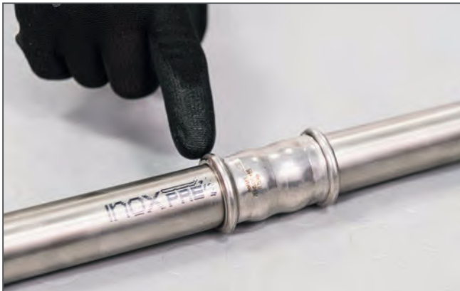
Controllo della pressatura / Checking the press connection
